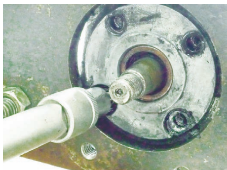
▲ 圖 7-46 安裝軸承蓋
